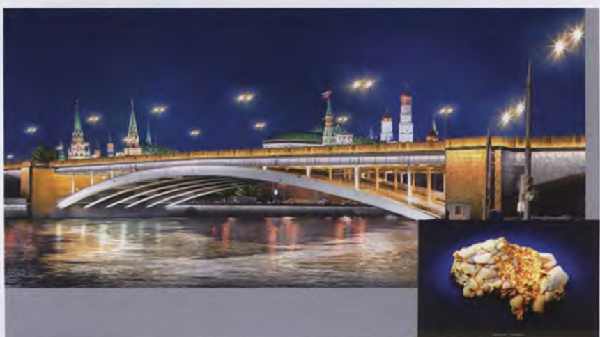
Рис. 3. Большой Каменный мост
