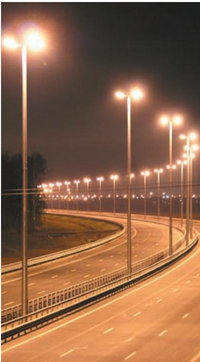
прокладывали кабели, устанавливали 10-метровые опоры освещения, светильники.
