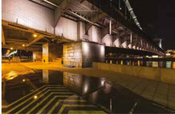
Для управления цветовыми характеристиками и внешним обликом объекта разрабатывается специальная программа, задающая поведение осветительным приборам. Светильники, установленные на Крымском мосту, обозначаются более чем 1000 адресов, которые должны быть учтены в программе. Это дает нам возможность создавать разнообразные эффекты вдоль световых линий, которые образуются линейными световыми приборами.
