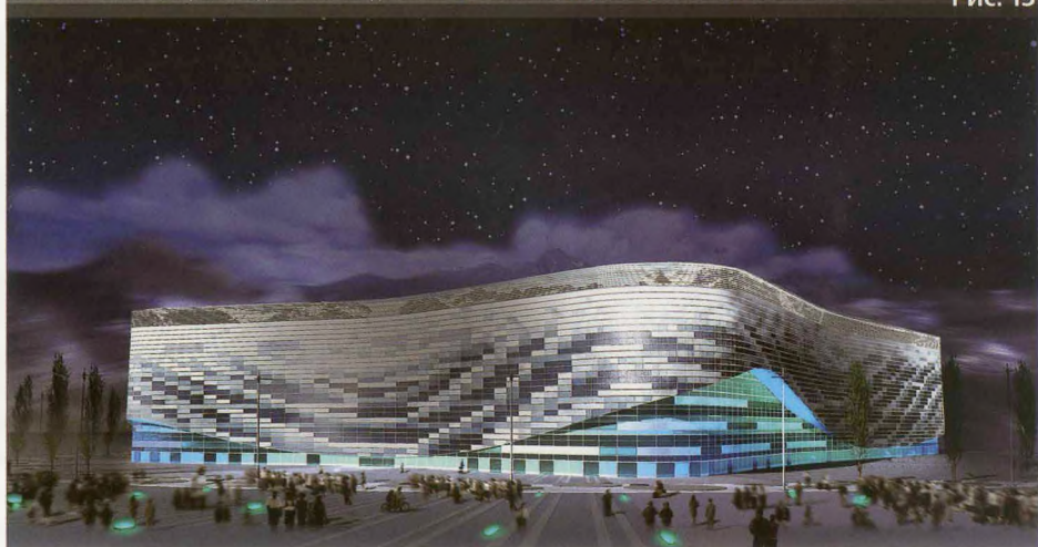
АРХИТЕКТУРНОЕ ОСВЕЩЕНИЕ БОЛЬШОЙ ЛЕДОВОЙ АРЕНЫ ДЛЯ ХОККЕЯ С ШАЙБОЙ НА 12 ТЫС. ЗРИТЕЛЕЙ
